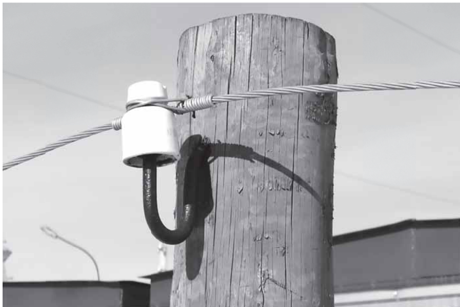
Рис. 1.4 – Штыревой изолятор напряжением до 1 кВ
